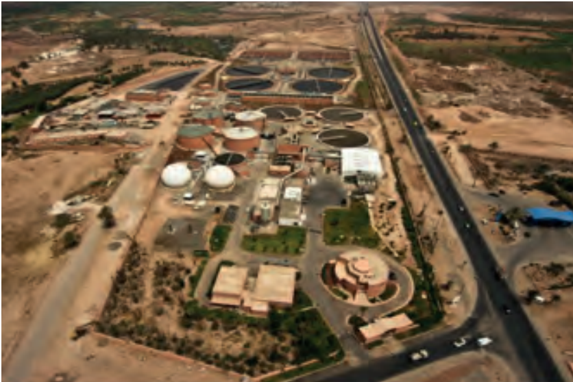
Photo 3 - Vue aérienne de la STEP de Marrakech Source : Présentation de la RADEEMA, 2012
