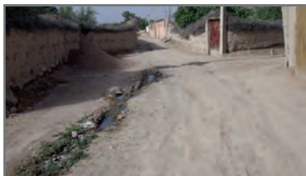
Evacuation des eaux usées à ciel ouvert, milieu rural (source : BET RESING)
