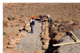
Disposition des couches de pierres sèches
