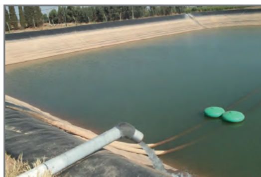
Bassin de stockage de l'eau d'irrigation (source : www.agire-maroc.ma)
