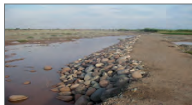
Aménagement d'une berge de l'oued (Source : ABHT)
