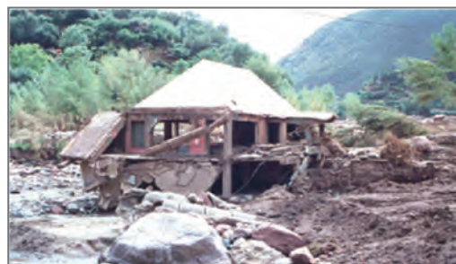
Constructions détruites par les crues, oued Ourika (Source : ABHT)
