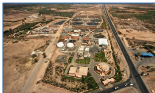
Vue aérienne de la STEP de Marrakech, 2012 (Source : RADEEMA)
