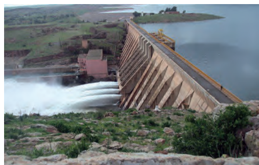
Photo 2 - Barrage Al Massira Source : ABHOER
