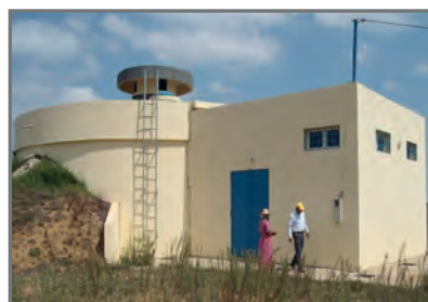
Château d'eau (Source : ONEE-Eau)
