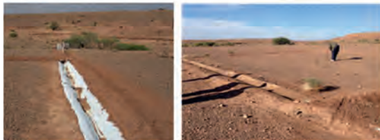
Terrassement et mise en place de la rigole (source : www.agire-maroc.org)
