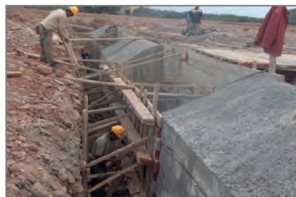
Travaux de construction d'un seuil (Source : ABHT)
