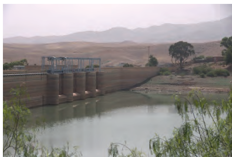
Photo 1 - Barrage Lalla Takerkoust Source : RESING
