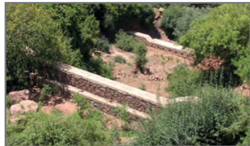
Seuils en gabions (source : programme AGIRE, www.agire-maroc.ma )
