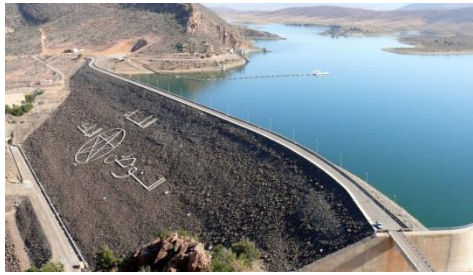
PHOTO 4: BARRAGE YOUSSEF BEN TACHEFINE
