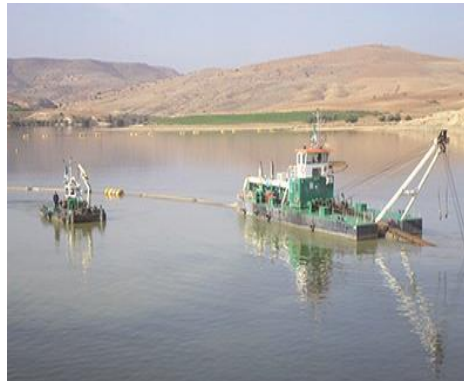
Schéma d'un système de dragage Dragage du barrage de Bou Hanifia
