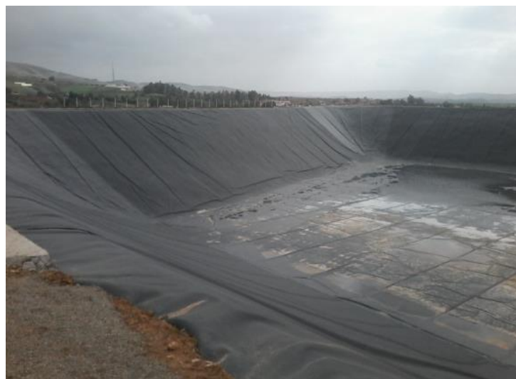
Le bassin de stockage de 300 000 m 3 , recouvert d'une géo membrane d'imperméabilisation
